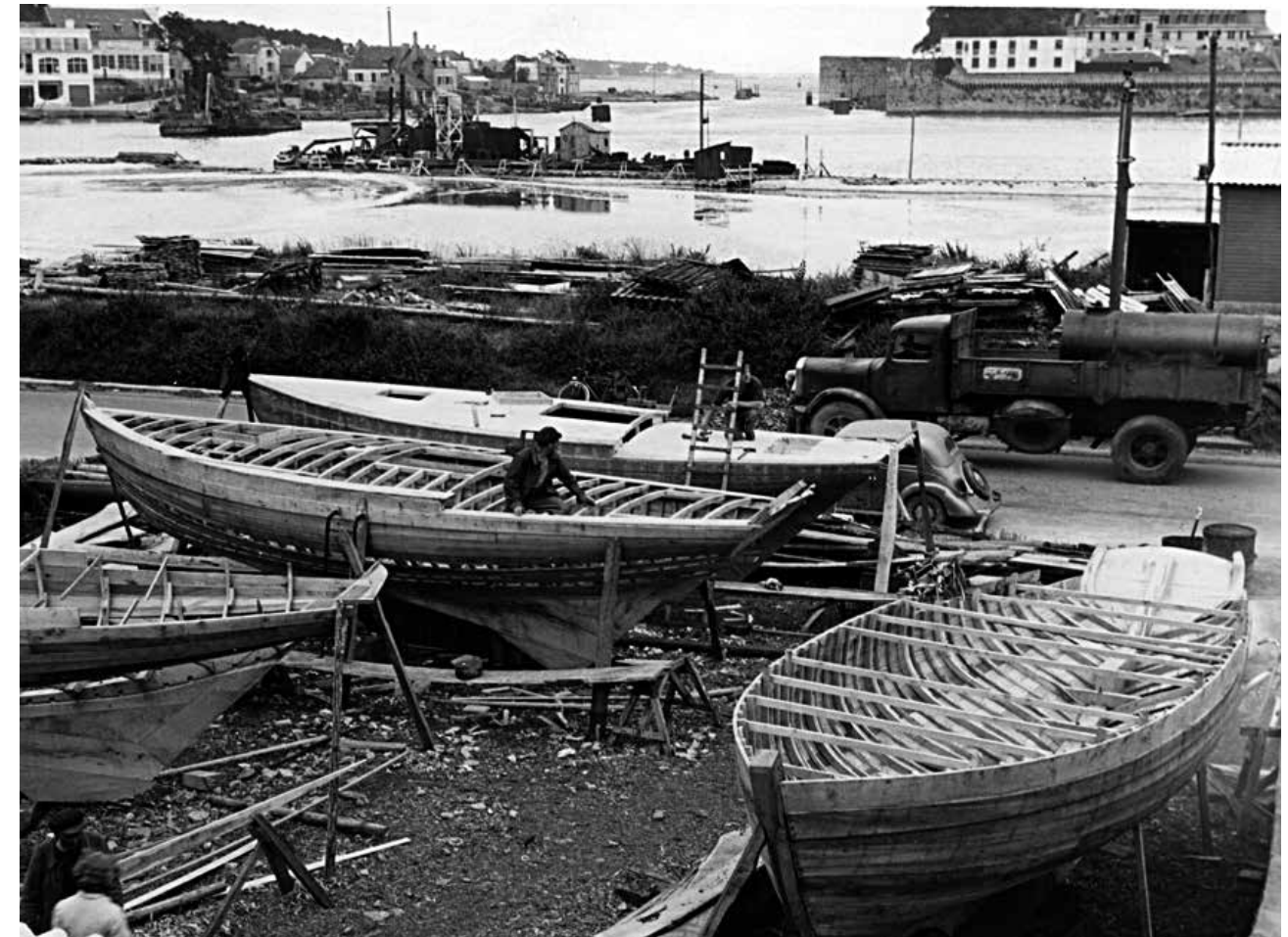
Cotres des Glénans en cours de construction, au chantier Le Goanvic à Concarneau au début des années 50.
